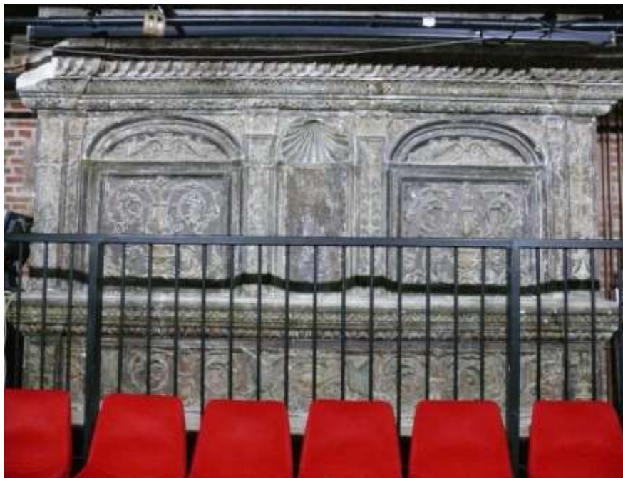
Vue de la cheminée dans sa situation actuelle.
