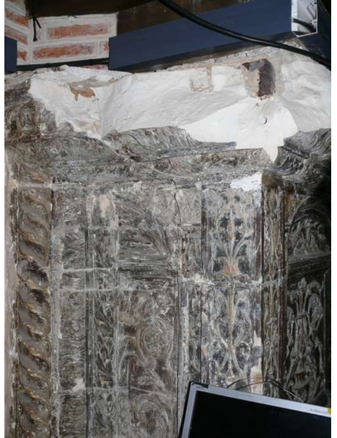
Vue latérale droite. Détail de l'archement de la corniche supérieure.
