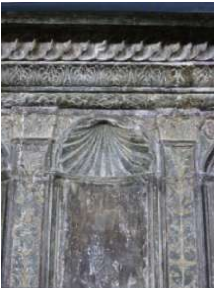
Détail de la hotte avec la niche centrale.
