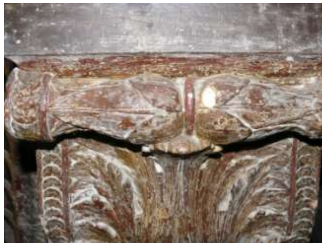
Détail du chapiteau des piédroits à corbeille feuillagée et balustre double.
