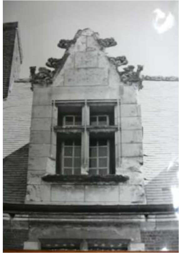
Figure 45 : Autre vue des lucarnes du logis royal. Cliché réalisé pour la campagne de pré-inventaire de 1974 des Monuments Historiques, MBAT.
