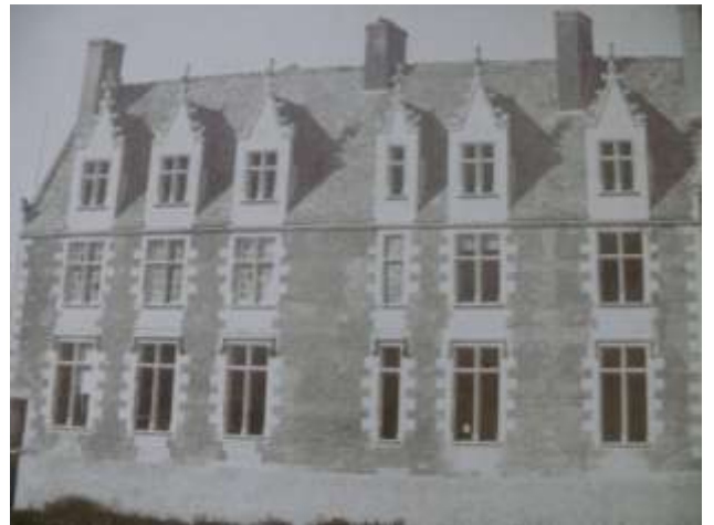
Figure 9 : Façade est restaurée.
