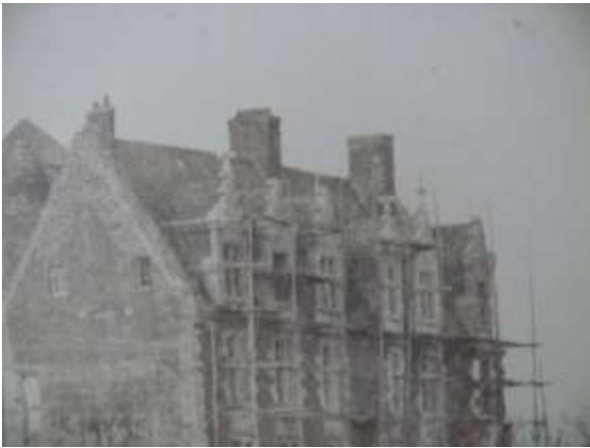
Figure 8 : Détail de la façade est en cours de réfection.
